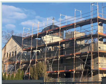
Neubau des Pfarrzentrums
